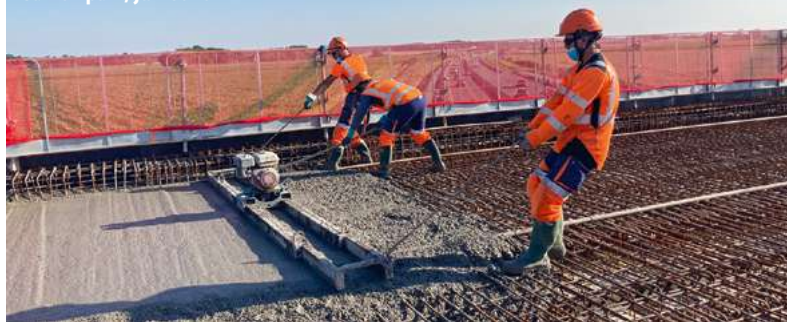
Bétonnage d'un tablier, Saint-Epain, juillet 2021
