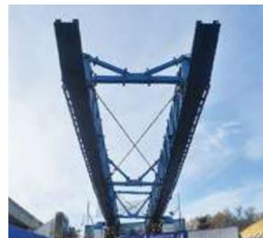
L'avant-bec de la structure métallique est prêt à avancer.
