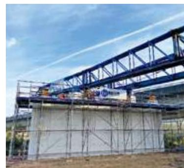
L'accostage de la charpente sur la pile est millimétré.
