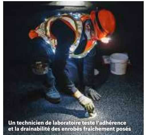
Sécurité : des dispositifs lumineux protègent les compagnons pendant les travaux nocturnes
