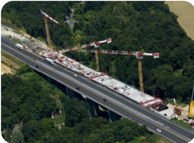
*Viaduc du Courteineau : construction du tablier coulé en place*
