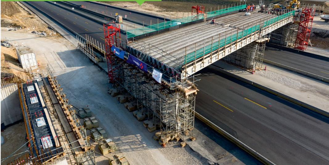
À moins d'un an de la fin des travaux, le futur diffuseur de Saran-Gidy se dessine nettement. Le nouveau pont est désormais visible des usagers. Après la construction des piles et des culées, 30 poutres ont été
