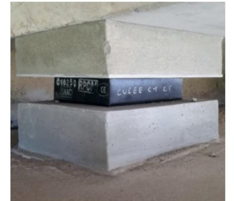
Les appareils d'appui font partie de la structure de l'ouvrage et ont un rôle essentiel dans son fonctionnement. Ils sont placés entre le tablier et les appuis de l'ouvrage (piles ou culée), et permettent la transmission des efforts appliqués sur les voies de circulation vers la structure du pont. Leur fonctionnement peut être comparé à celui d'amortisseurs.
