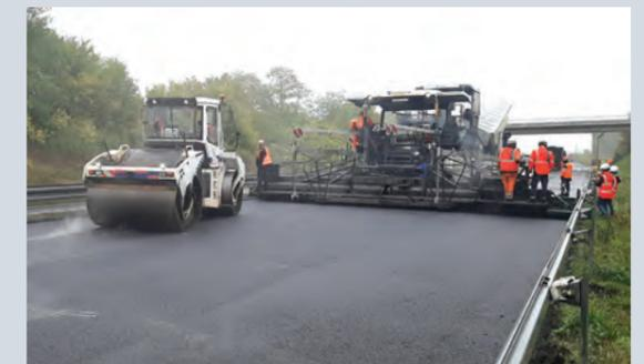
Le chantier est réalisé sans coupure de la circulation et seuls des basculements de la circulation sont mis en place au niveau de ce chantier mobile. Des fermetures d'échangeurs seront nécessaires lors du passage du chantier au niveau des sorties ou entrées. Des itinéraires de déviation sont alors proposés et communiqués via différents moyens d'information (voir p.8).
