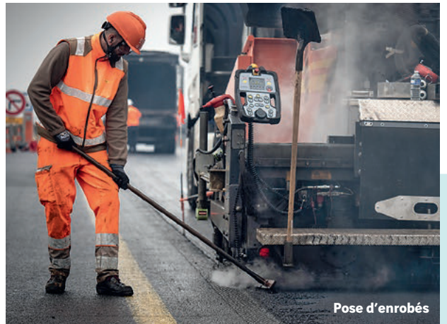
Échangeur de Monts-Sorigny (n°24.1) : aménagement des bretelles
