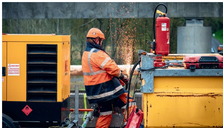
Pose de barrières de sécurité
